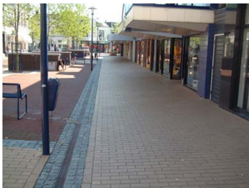
bestaande lijngoot met grijsblauwe granietkeien vormt goed contrast met gele klinkers
